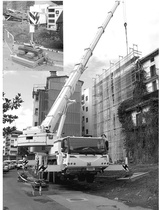
Figura 12. Ejemplo de colocación de elementos suplementarios en los apoyos de los estabilizadores de una grúa móvil
