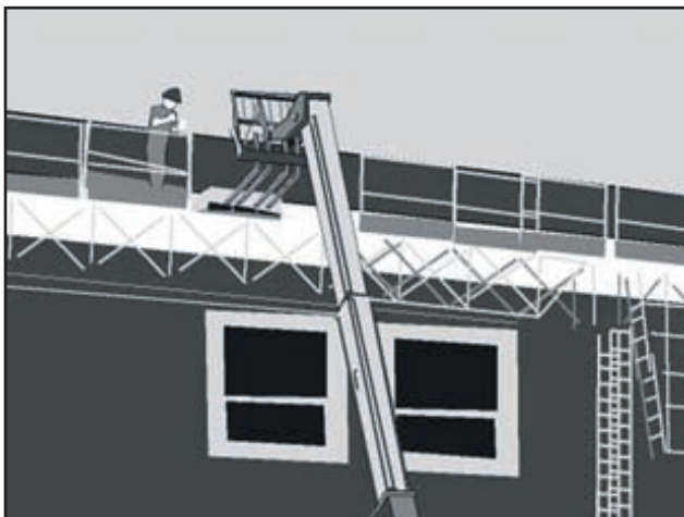
Figura 35. Incorrecta interrupción temporal de la protección colectiva contra caídas sin medidas compensatorias y eficaces de seguridad
